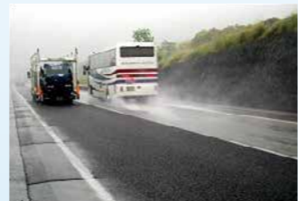
「高機能舗装施工前後の路面状況」 (左車線：高機能舗装・右車線：従来舗装)
