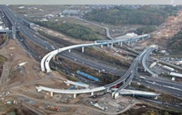
上部工は、コンクリート桁の施工が完了し、鋼橋についても桁の架設が完了し、床板や壁高欄の工事を進めています。土工工事も大型重機を用いて盛土造成を進めています。
