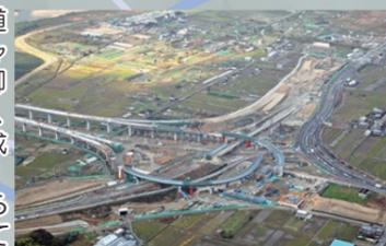
おり、約7割の架設が完了。また鋼桁は、京奈道路夜間通行止め架設などを行い、約9割が完了しています。土工事は、八幡ジャンクションからの掘削土を運搬して、盛土造成を行っています。
