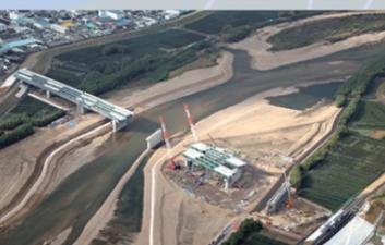
橋脚については、全16基のうち14基が完成しており、残る橋脚を施工していきます。上部工も順次架設を行っており、左岸側は3径間、右岸側は1径間の架設が完了しています。
