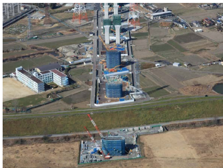
⑤ 橋梁下部工の施工を行っております。
