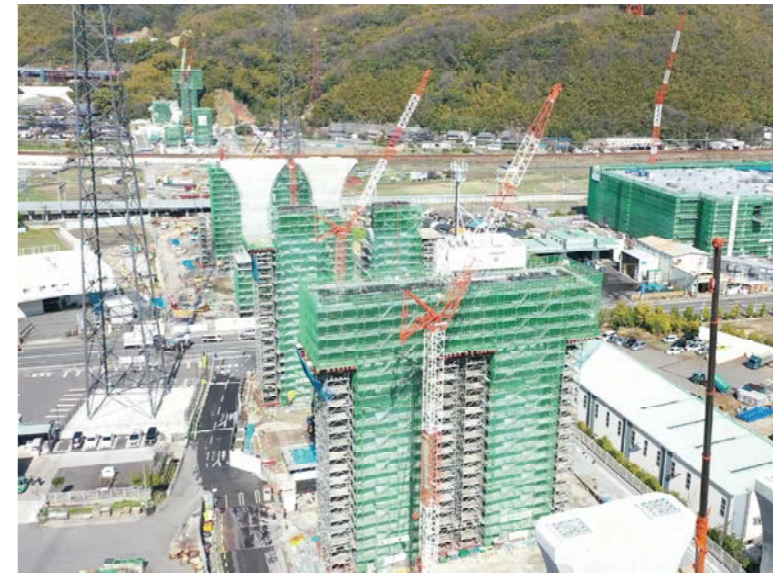
④ 橋梁下部工の施工を行っております。
