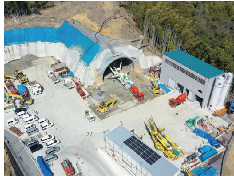
② トンネルの掘削を行っております。
