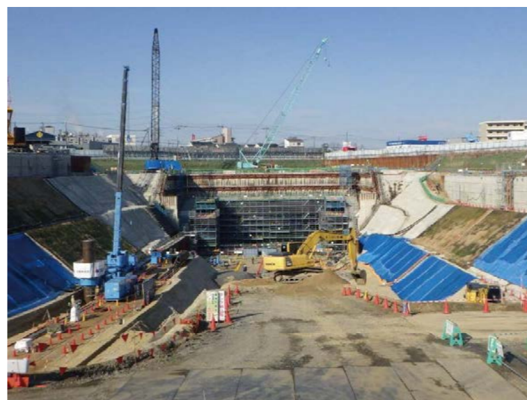
⑦ 掘割区間の掘削および、鋼管擁壁の施工を行っております。
