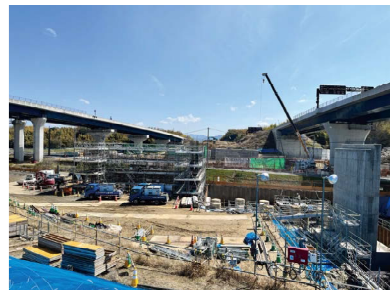
⑧ 橋梁下部工の施工を行っております。
