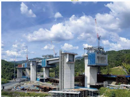
① 橋梁上部工の張出架設を行っております。
