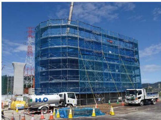
⑤ 橋脚の施工を行っております。
