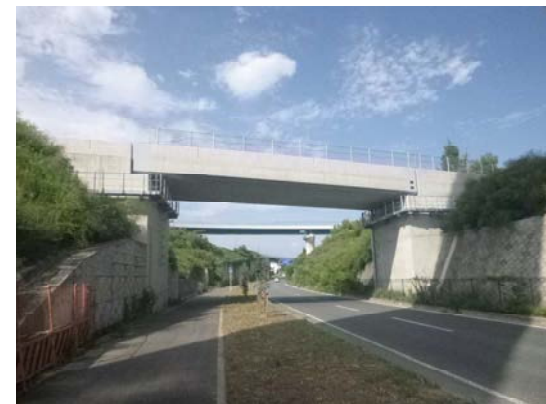
⑧ ランプ橋の施工が完了いたしました。
