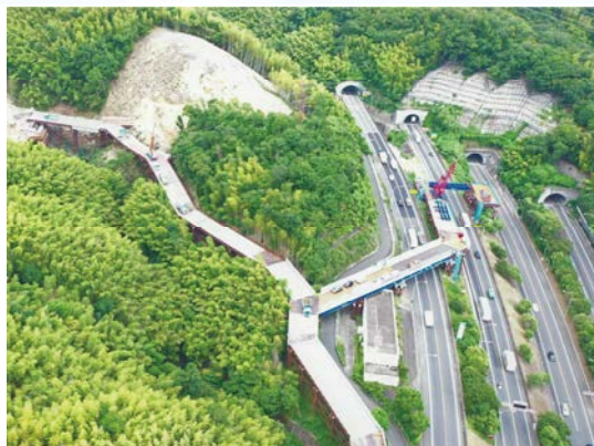
② トンネル掘削に向けたヤード造成・橋脚施工に向けた仮橋施工を行っております。
