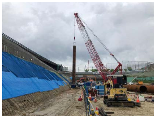
⑦ 鋼管を埋め込み、擁壁工の施工を行っております。
