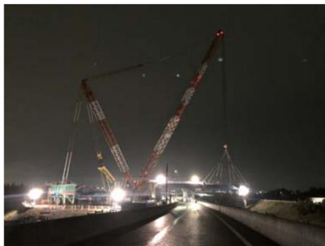
施工方法としては大型クレーンを用いて主桁の架設を行っていくクレーンベント工法が用いられています。
