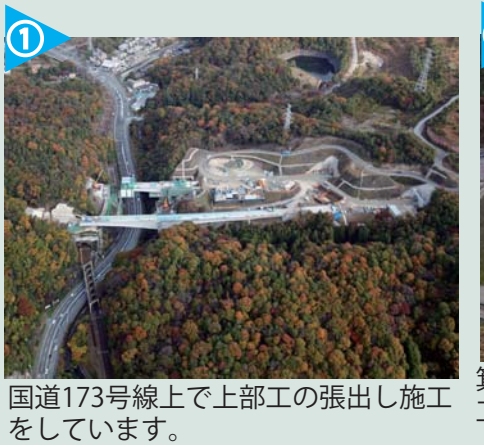
東畦野トンネル東坑口よりコンクリート工事や北山川橋の上部工工事を実施しています。
