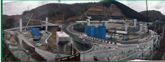
箕面有料道路と近接した箇所では切土工事や橋梁工事を実施しています。また、箕面トンネル西坑口より掘削作業中です。
