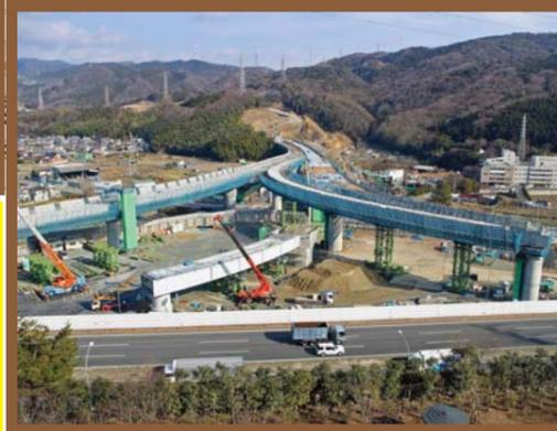
全下部工40基本中39基が施工完了しています。上部工工事の桁架設及び床版工事も実施しています。
