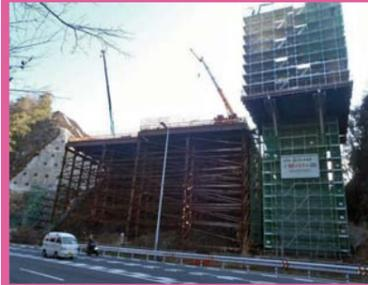
上り線（高槻方面車線）は国道173号線東側で橋脚の構築を行ってまいります。
