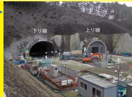
神峰山トンネル西坑口より、上下線が貫通しました。引き続き、コンクリート工事を実施しています。
