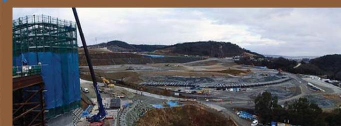
高槻砕石跡地での高盛土工事を実施しています。大型ダンプトラック（36t）8台を使用した盛土工事を実施しています。
