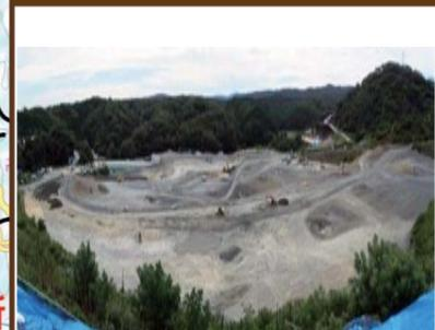
高槻砕石跡地での高盛土工事を実施しています。大型ダンプトラック(36t)6台を使用した盛土工事を実施しています。
