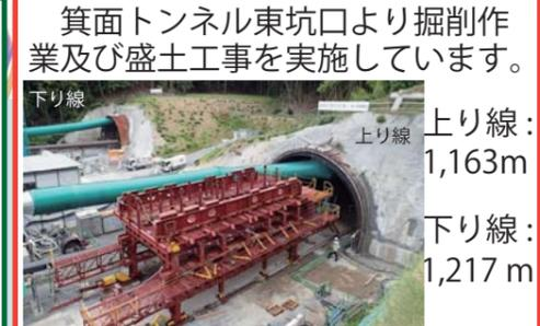
箕面トンネル東坑口より掘削作業及び盛土工事を実施しています。また、佐保川橋の下部工工事を実施しています。
