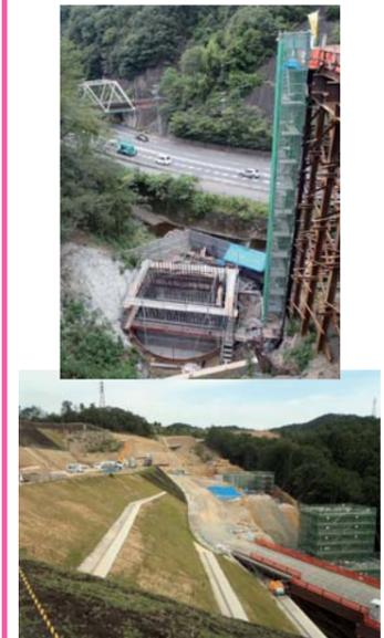
本線の切土工事は概成し、現在塩川橋・平野橋の下部工9基(完了:2基 施工中:4基)の作業を実施しています。今後は、国道173号線東側で橋脚の構築を行ってまいります。
