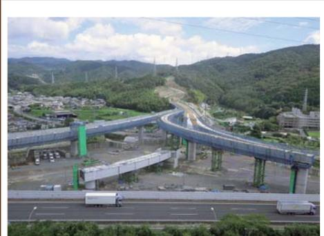
全下部工40基本中37基が施工完了しています。上部工工事の桁架設及び床版工事を実施しています。
