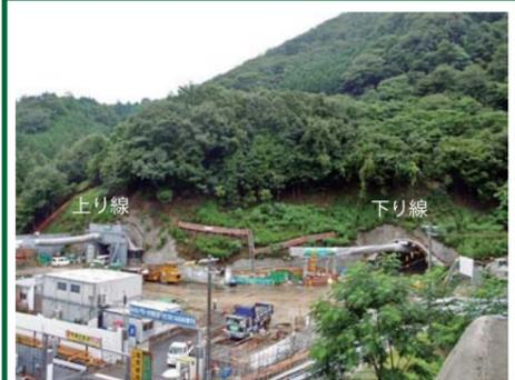
箕面有料道路と近接した箇所切土工事や橋梁工事を実施しています。また、箕面トンネル西坑口より掘削作業中です。
