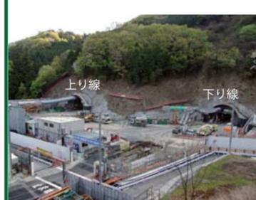
箕面有料道路と近接した箇所にて切土工事や橋梁工事を実施しています。また、箕面トンネル西坑口より掘削作業中です。
