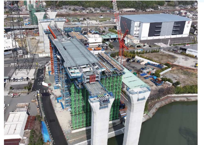
④ 橋梁上部工の送出し架設に向けた準備を行っております。
