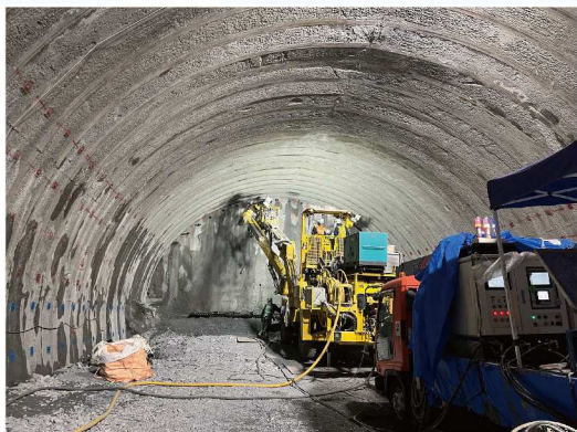
② トンネルの掘削を行っています。
