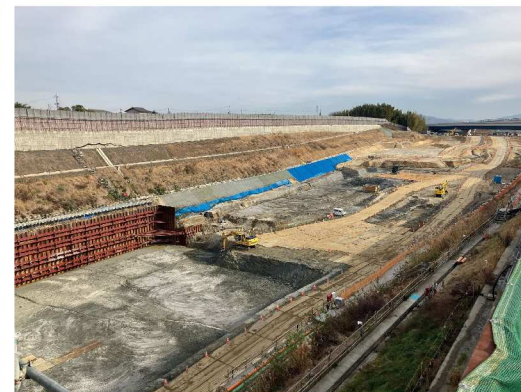
⑧ 掘削区間の施工を行っています。
