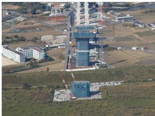
⑤ 橋梁下部工の施工を行っています。
