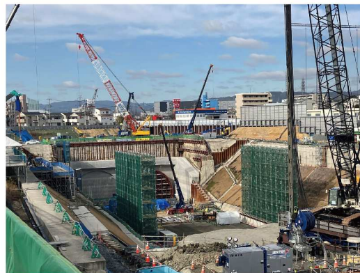
⑦ トンネル掘削のための準備工の施工を行っています。
