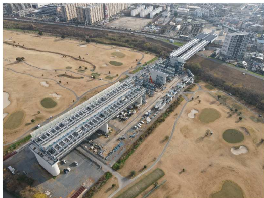
⑥ 橋梁上部工の施工を行っています。
