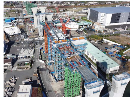
④ 橋梁上部工の送り出し架設に向けた準備を行っています。
