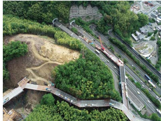
② 橋梁下部工・トンネル施工に向けた工事用の仮橋施工を行っております。
