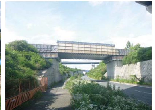
⑧ ランプ橋の施工を実施しております。
