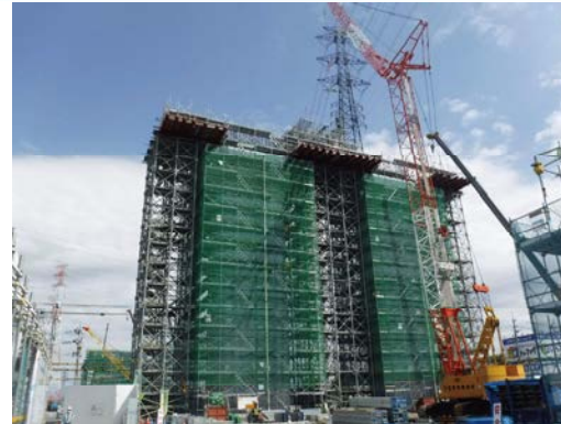
③ 橋梁下部工の施工を行っております。
