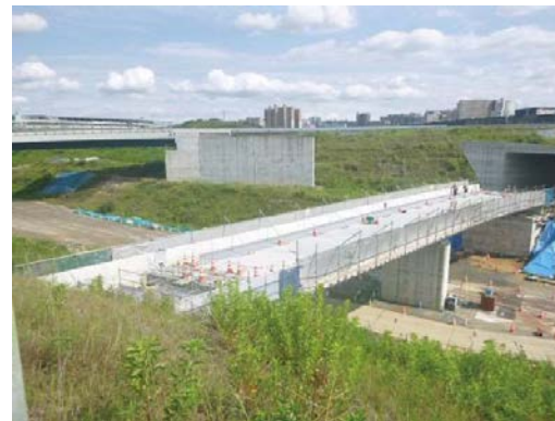
⑦ 壁高欄の施工が完了。今後、橋面の仕上げ及び付属物の施工を実施していきます。
