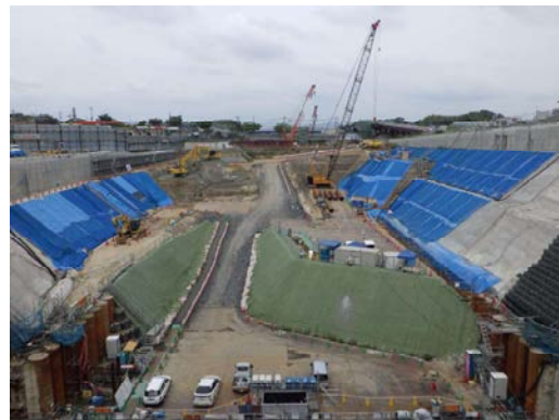
⑥ 掘割区間の地面を掘り下げております。 (山手幹線西側)
