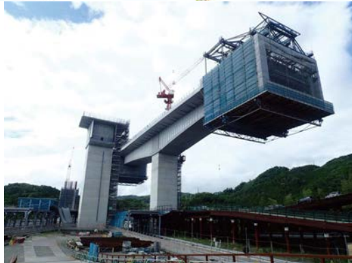
① 橋梁上部工の施工を行っております。
