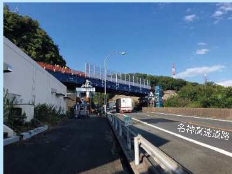
② 橋梁下部工施工のために仮橋を設置しました。
