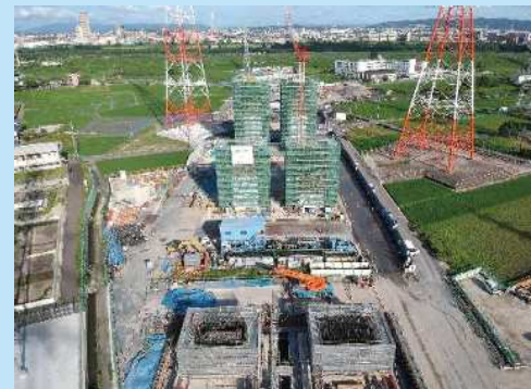
④ 橋脚下部工のコンクリート打設を行っています。
