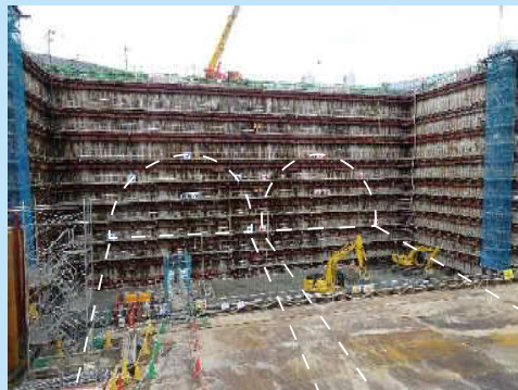
⑥ (左) 掘削区間の地面の掘り下げを行っております。 (右) トンネル入口（東側）の発進立坑施工のために地面を掘り下げています。
