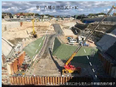
⑥ (左) 掘削区間の地面の掘り下げを行っております。 (右) トンネル入口（東側）の発進立坑施工のために地面を掘り下げています。
