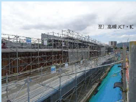
⑤ 盛土部分の擁壁（コンクリート構造物）を施工しております。
