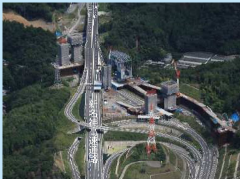
① 橋梁上部工の張り出し架設を行っております。
