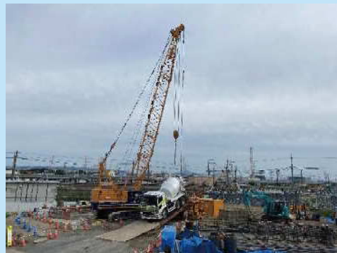
③ 橋梁下部工の施工を行っています。
