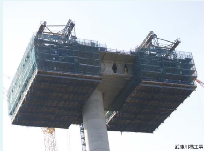
武庫川橋工事
