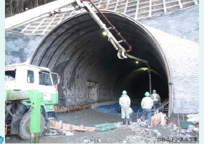
六石山トンネル工事
