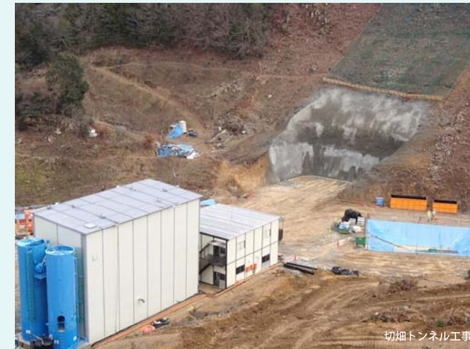
切畑トンネル工事
