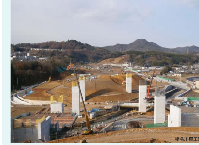
猪名川東工事
