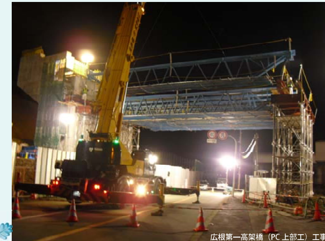
広根第一高架橋(PC上部工)工事
