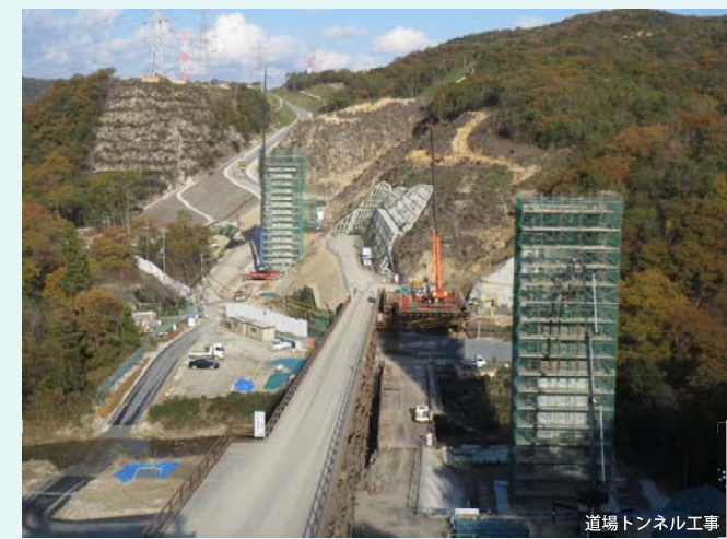
道場トンネル工事
