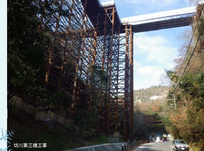
坊川第三橋工事
