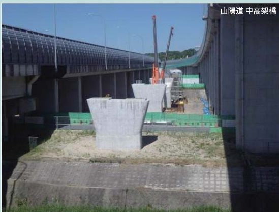
山陽道 中高架橋
