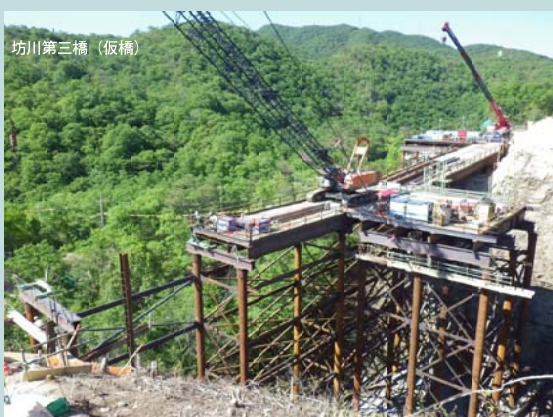
坊川第三橋(仮橋)
