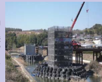
橋脚部の施工（一庫大路次川）
