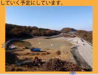
猪名川町域東側の高速道路、付替町道、付替河川 等を構築する工事です。現在、埋蔵文化財発掘調査 が完了した場所から橋梁工事や盛土工事を行ってい ます。写真は、町道差組紫合線を横過する広根第一
