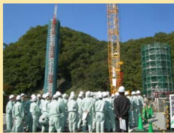
H24.11.1 武庫川橋工事に
