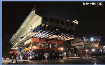
撤去OVB撤去状況
