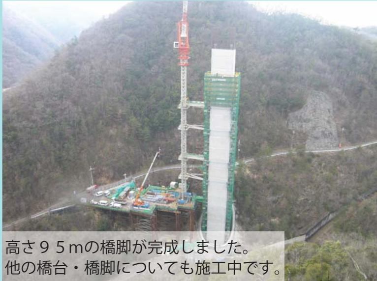
高さ95mの橋脚が完成しました。他の橋台・橋脚についても施工中です。
