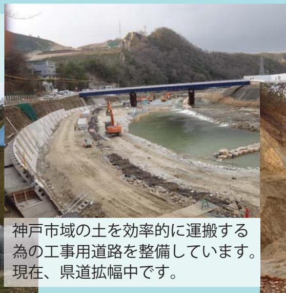
神戸市域の土を効率的に運搬する為の工事用道路を整備しています。現在、県道拡幅中です。
