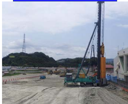
地盤改良工事
