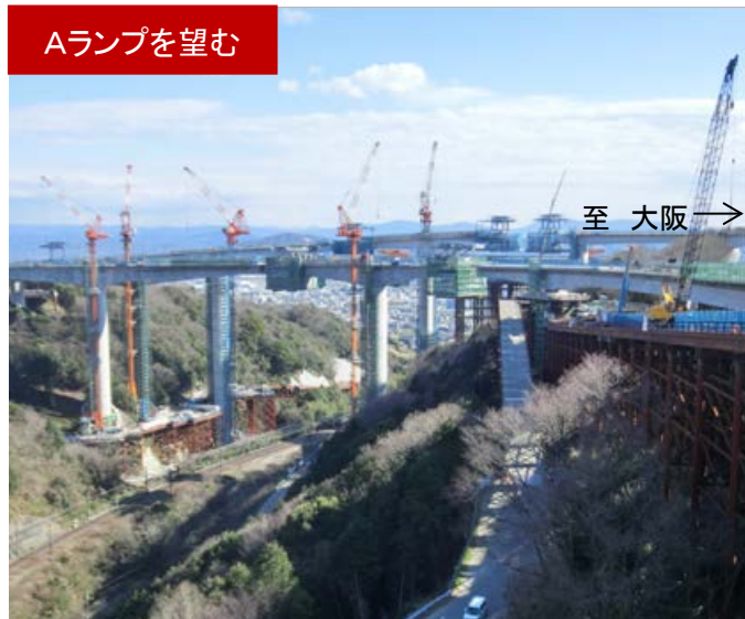
Cランプ主桁架設完了
