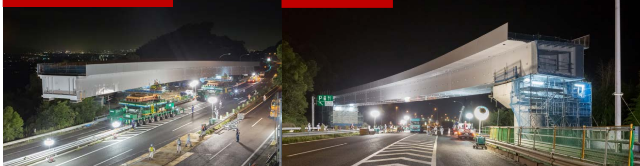
多軸台車による一括架設
