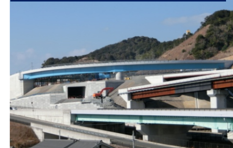
南紀田辺IC(国道42号より望む)
