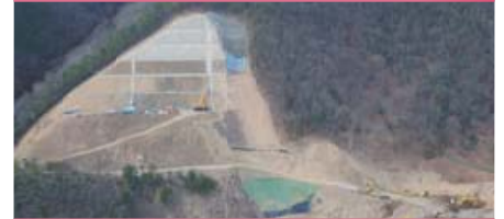
山の切土を行って、盛土を構築しています。
