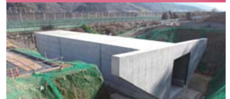
本線を横断するカルバートボックスの施工を行っています。
