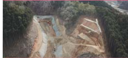
筋原トンネル 切土・盛土を構築しています。
