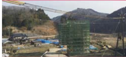
本線の橋梁下部工を行っています。
