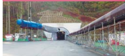
全長2,709mの国見山トンネルの約7割まで掘削を進めています。
