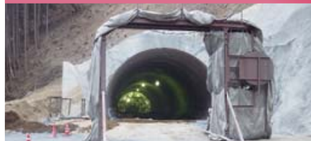
奥小屋トンネル(1,227m)は、貫通しました。
