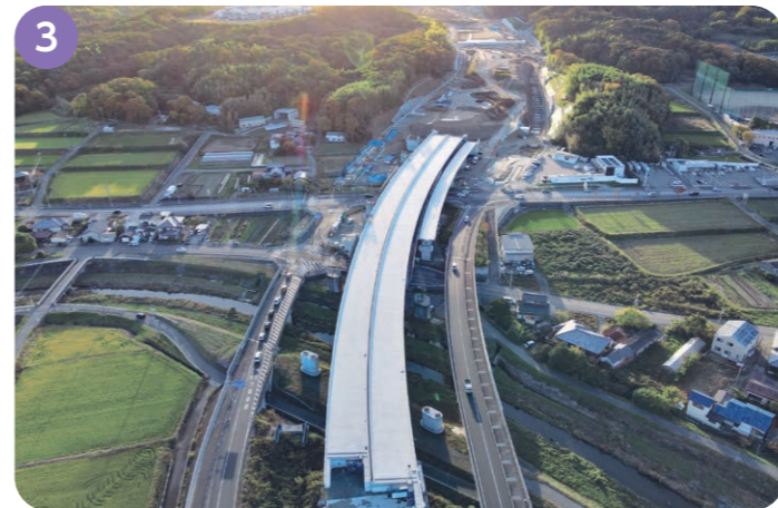
菅野交差点付近 県道明石木見線、榎谷川を横架する専用部の橋梁工事は概ね完了しました。
