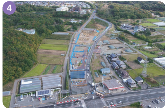
下村地区 橋台、橋脚を構築する工事を行っています。西消防署前交差点付近の樹木伐採に着手しました。
