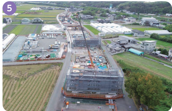
平野地区 橋台、橋脚を構築する工事を行っています。
