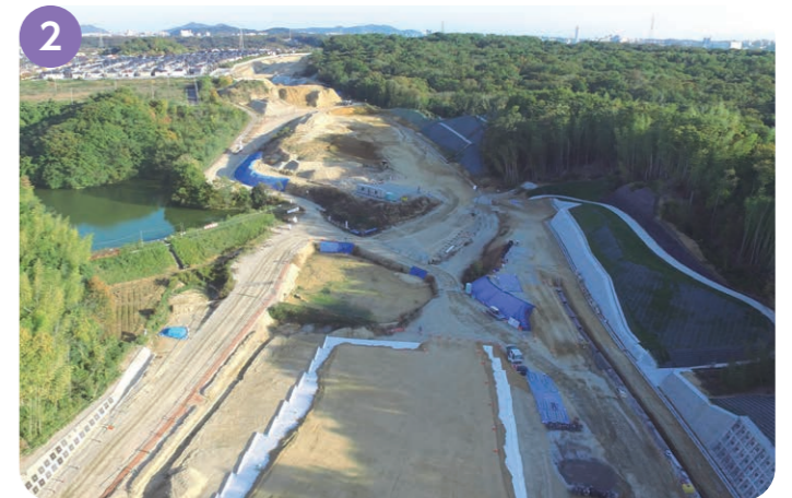
榎谷IC付近 山を道路の高さまで掘削する工事を行っています。
