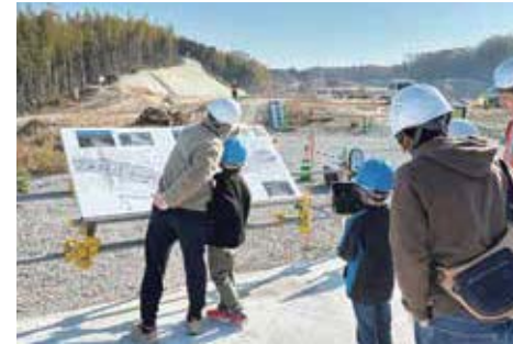
櫛谷工事現場見学会 2023.12.10
