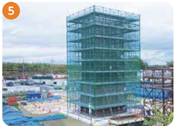
石ヶ谷 JCT 付近 明石川右岸側では橋脚の構築を行っています。
