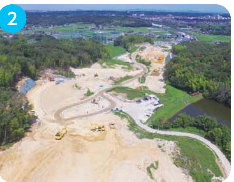
2 櫛谷IC付近 永井谷JCTから県道明石木見線と交差する間において、山を掘削する工事を実施しています。
