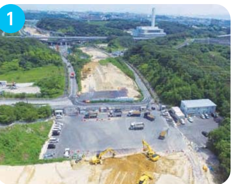
1 永井谷JCT付近 永井谷JCTにおいて、橋台、橋脚の基礎工事を実施しています。
