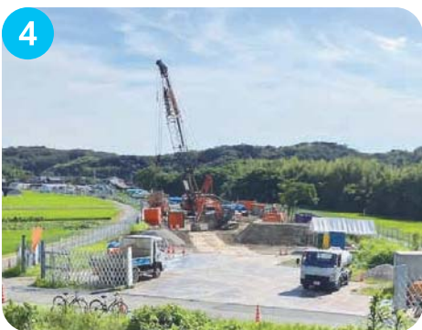
4 平野西IC付近 橋脚の基礎工事を実施しています。
