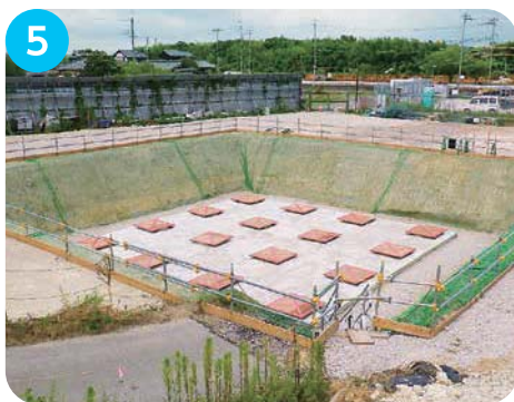
5 石ヶ谷JCT付近 橋脚の基礎工事に着手しました。
