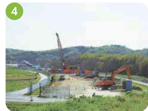
4 平野西IC付近 橋脚の基礎工事に着手しました。
