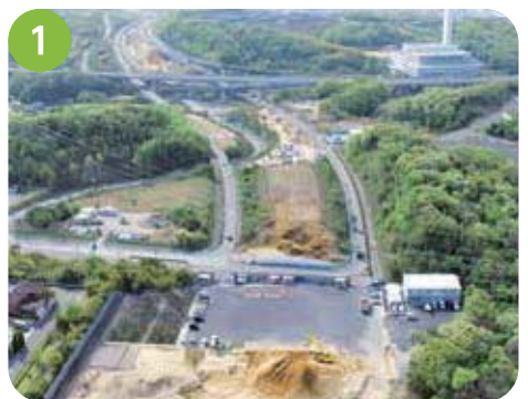
1 永井谷JCT付近 永井谷JCTから西に向かって道路の計画高さまで山を掘削する工事を実施しています。また、永井谷JCTにおいて橋脚の基礎工事に着手しました。
