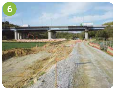
6 石ヶ谷JCT～明石SA 付加車線事業の工事が必要となる工事用道路の工事を実施しています。
