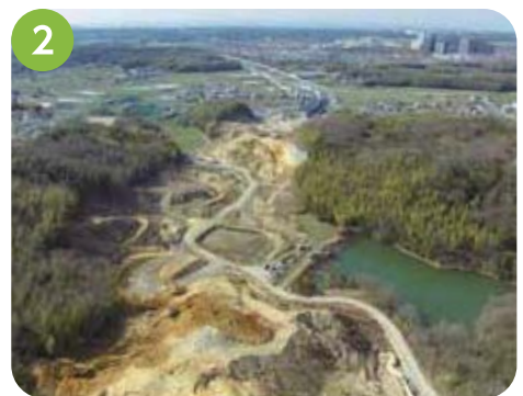
2 榎谷IC付近 県道小部明石線から東に向かって道路の計画高さまで山を掘削する工事を実施しています。
