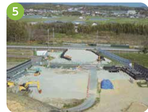
5 石ヶ谷JCT付近 橋梁工事に必要なヤード整備を行っています。今後、橋脚の基礎工事に着手する予定です。
