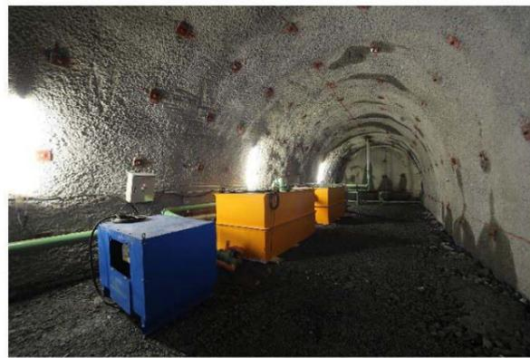
返水横坑先端部の返水設備 (水槽・ポンプ)
