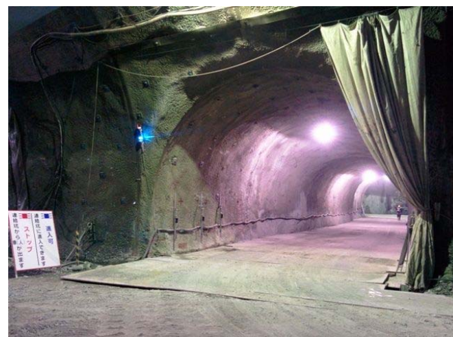
第2連絡坑掘削完了
