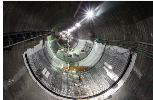
下り線 WTインバート施工状況
