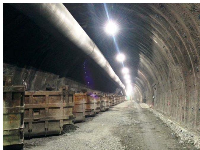
ベッセル坑内仮置き状況
