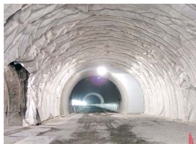
非常駐車帯部施工状況
