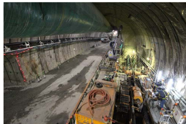
上り線 コントロールポーリング施工状況
