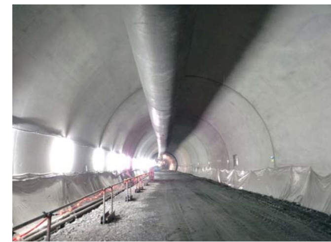
上り線覆工コンクリート打設完了
