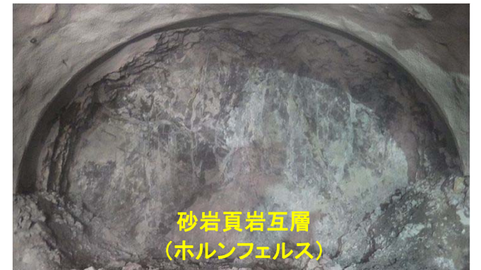
上り線 TD612m 切羽状況
