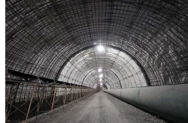
上り線 WTアーチシート・鉄筋施工状況
