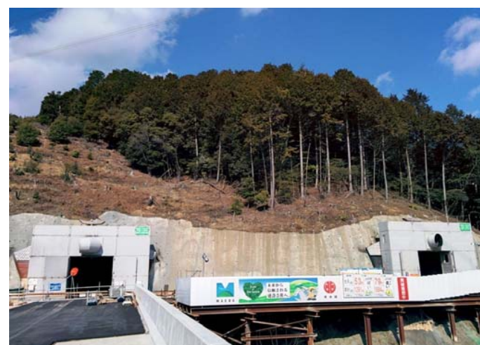
トンネル上下線東坑口
