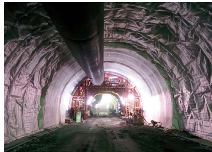
覆工防水工施工状況
