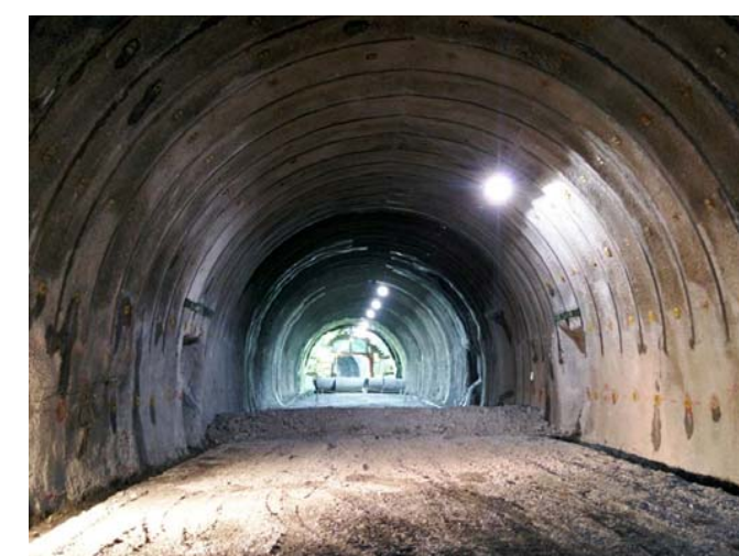
上り線貫通点(東工区から西工区を望む)
