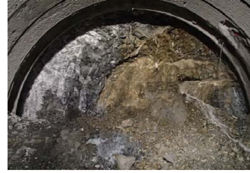
③TD1541m（Ft2断層破碎帯） 切羽より2 t/min出水
