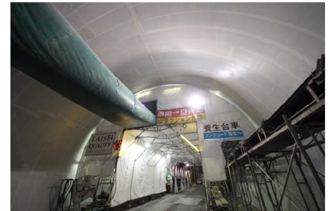
上り線 WTアーチ覆工施工状況
