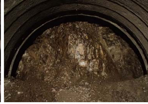
①TD1450m（Fewb3断層破碎帯）
