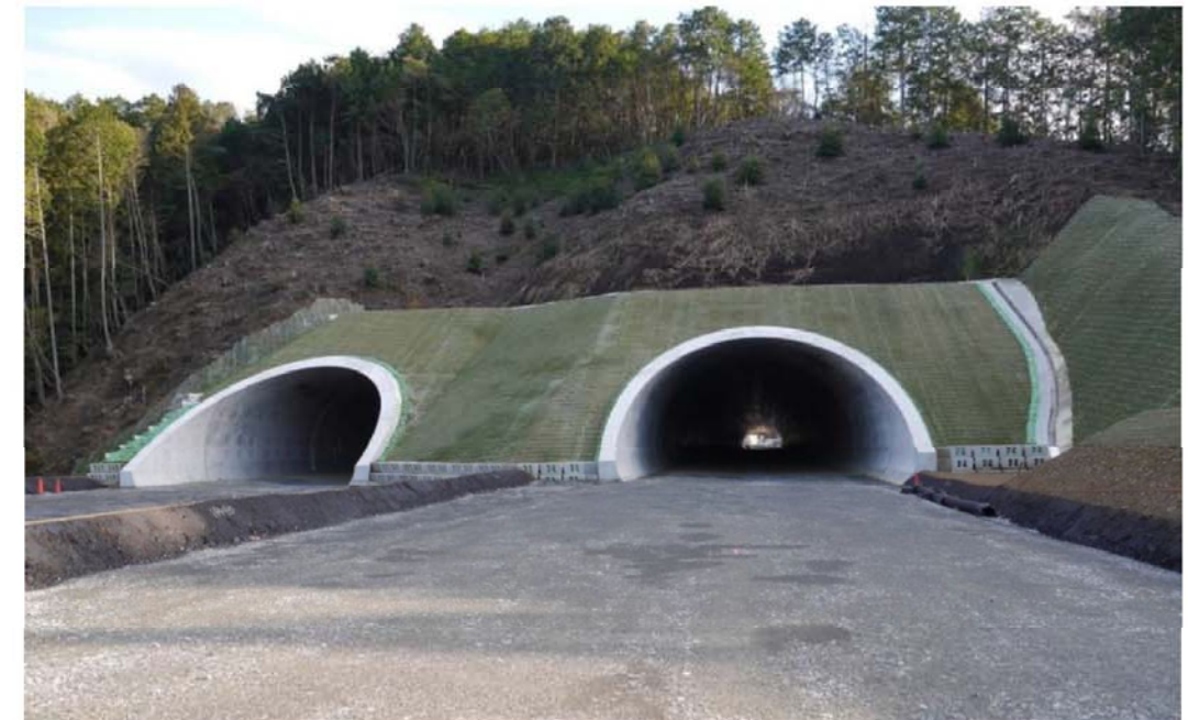
神峰山トンネル西側坑口全景
