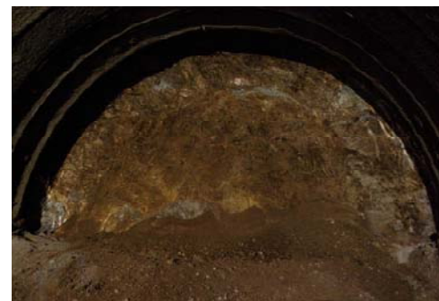
⑥TD1600m（Fewb3断層破碎帯）
