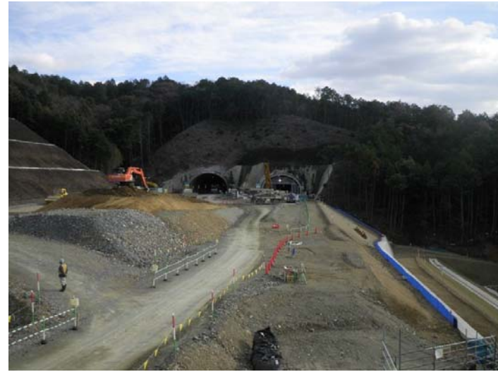
終点側坑口ヤード 全景
