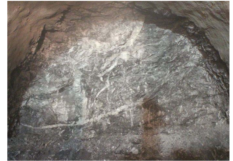
上り線 STA.148+34.8(C II -a(H)-B) 切羽状況①(砂岩・頁岩)
