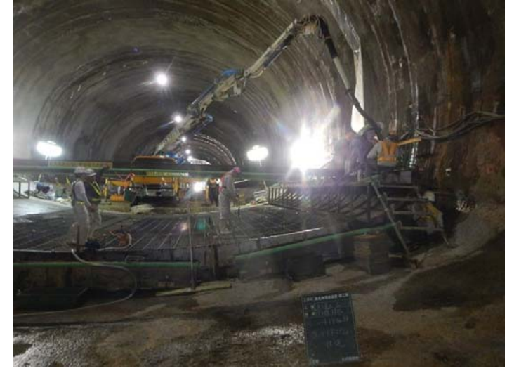
下り線 インバートコンクリート 施工状況
