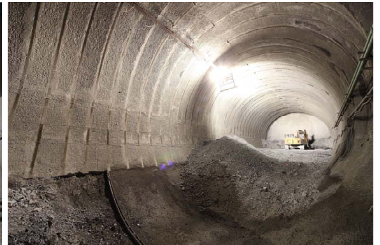
WT区間トンネル掘削工（上り線 WTO.75DI）
