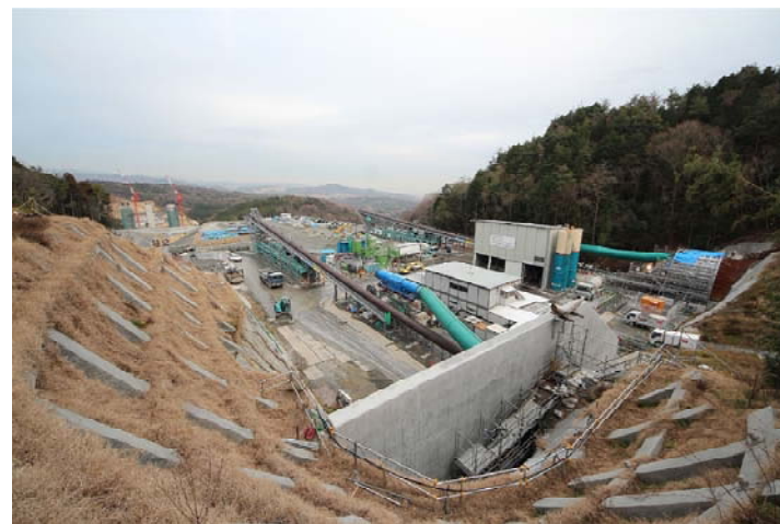
坑口施工ヤード全景
