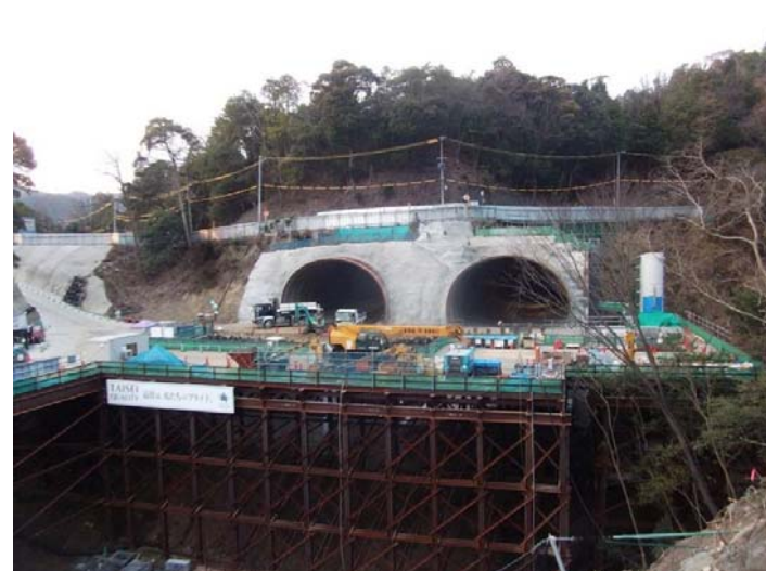
起点側坑口ヤード 全景
