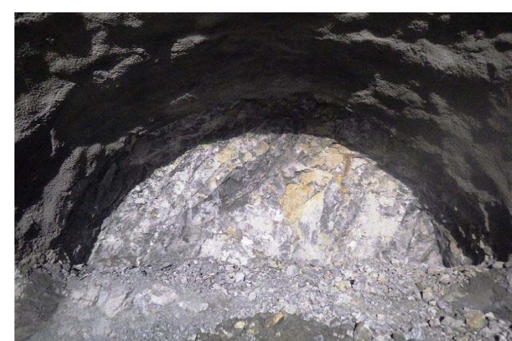
下り線切羽状況 STA.127+38.6 TD=468.6m C I -a 湧水なし(切羽)、25L/min(下り線全体)
