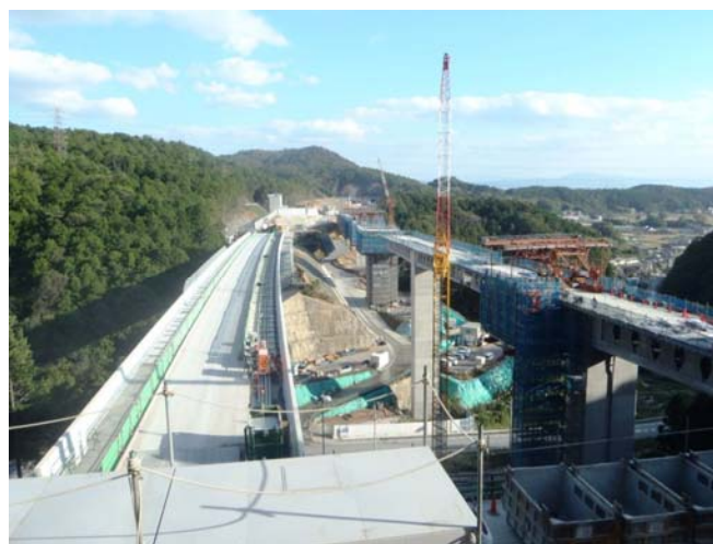
上り線坑口部より起点側全景
