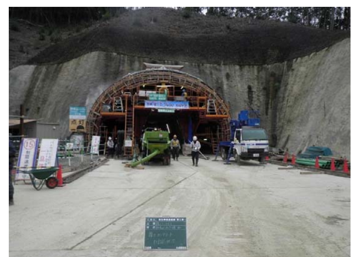
下り線 覆工コンクリート 施工状況
