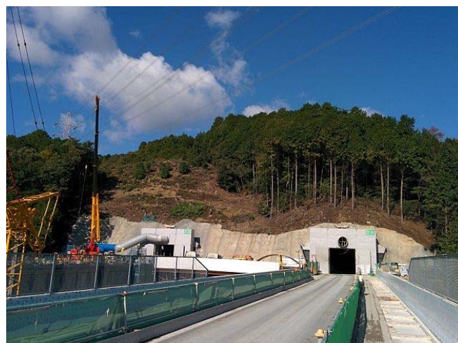
上下線トンネル坑口部
