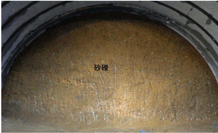
下り線 STA.114+35 切羽状況
