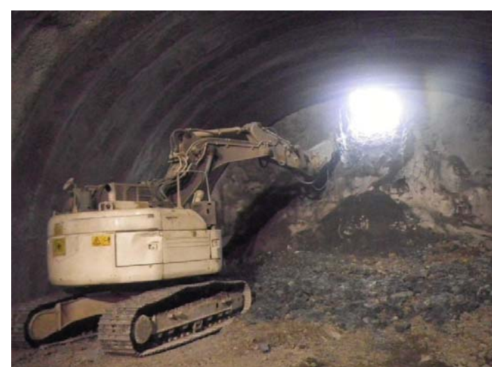
上り線 貫通掘削状況
