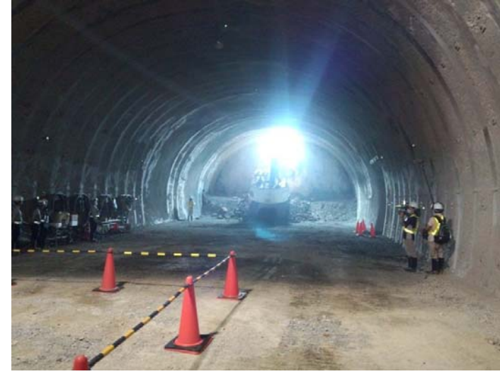
下り線 貫通掘削状況
