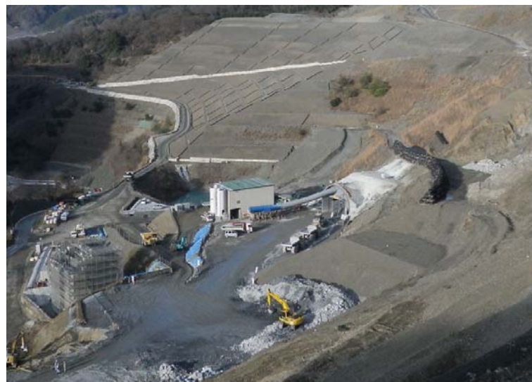
上り線坑口部仮設備ヤード
