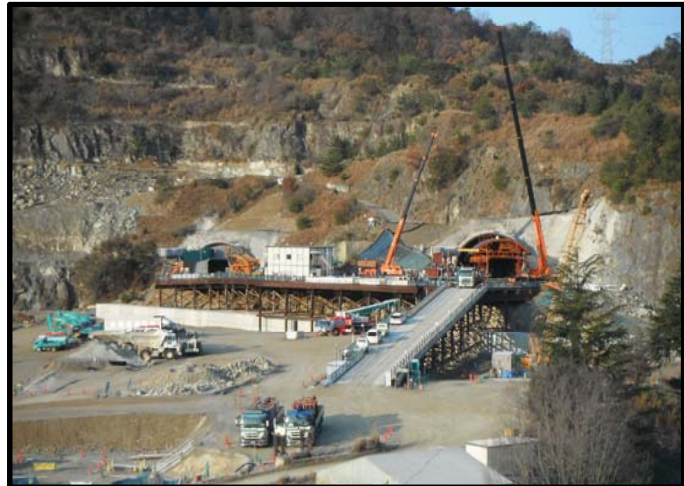
坑口前ヤード 全景
