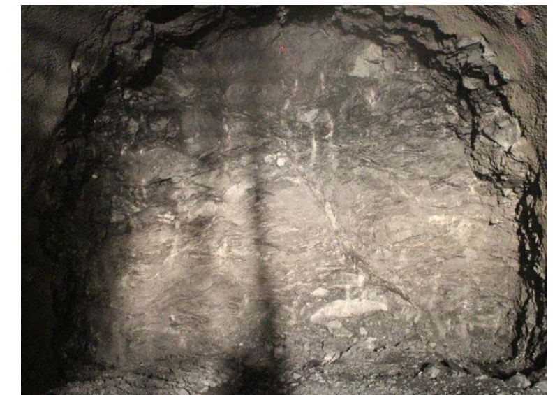
避難連絡坑 (C I -B -SL) 切羽状況②(砂岩・頁岩)
