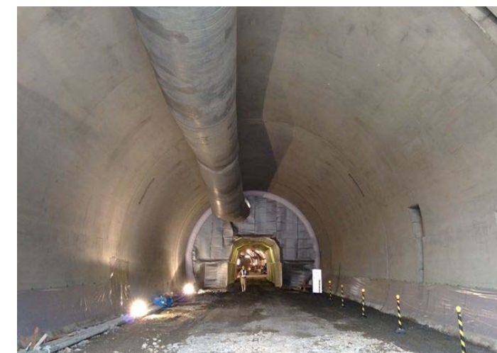
上り線坑口側(覆工打設完了)
