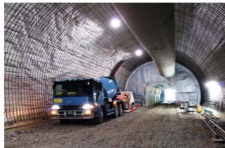
覆工コンクリート打設状況
