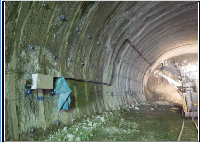
採石場重ダンプ走路部 B計測計器設置
