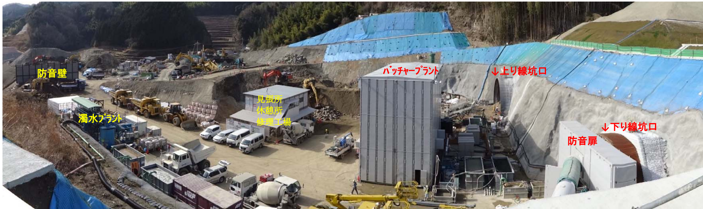
西側坑口ヤード 全景
