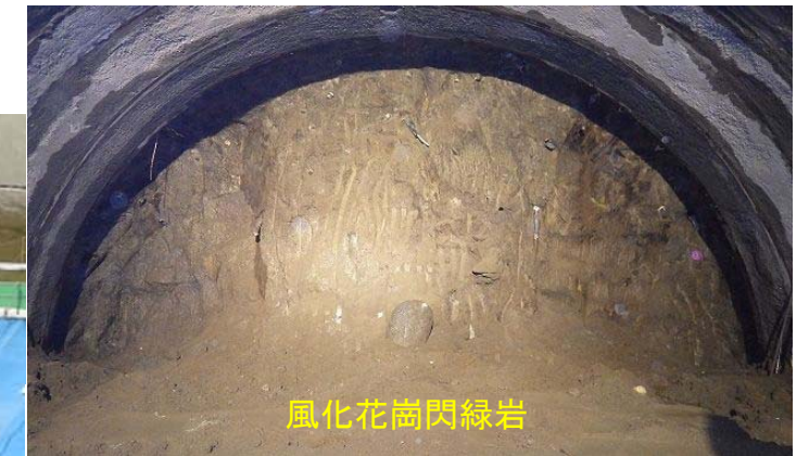
下り線 STA.180+76.9 切羽状況
