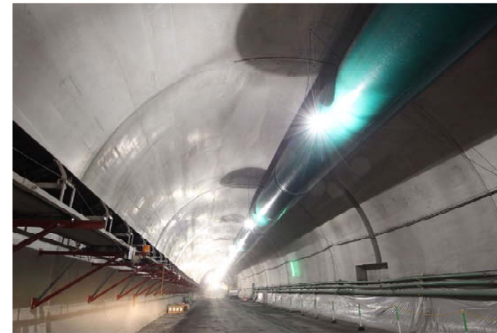
覆工コンクリート工（上り線）
