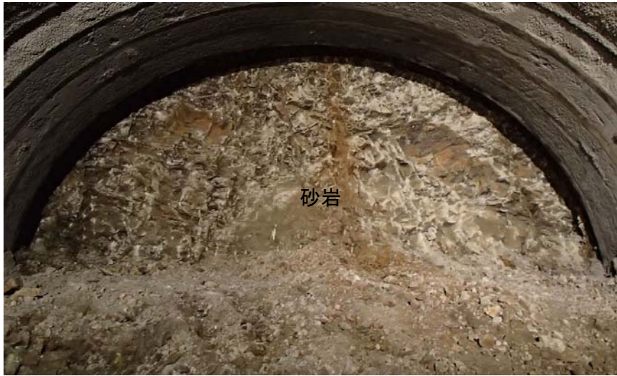
下り線 STA.111+72 切羽状況
