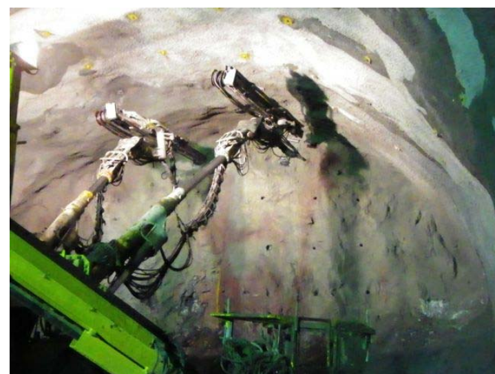
削孔状況 (非常駐車帯)
