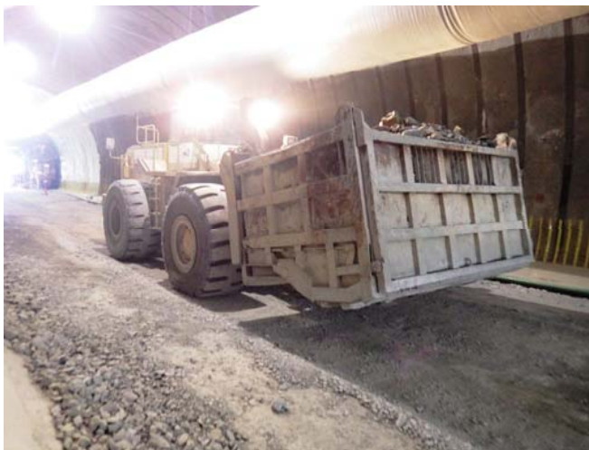
ベッセル坑内運搬状況
