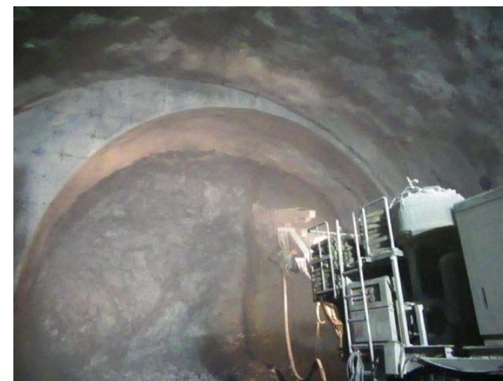
吹付け状況 (C II -a)
